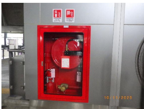
รูปที่ 2-17 การติดตั้งระบบป้องกันและระงับอัคคีภัยบริเวณสถานีรถไฟฟ้ามหานครตามมาตรฐาน NFPA 130
