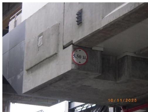
รูปที่ 2-8 ระยะความสูงของช่องลอดจากผิวจราจร (Vertical Clearance)
