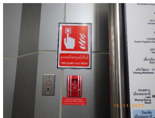
รูปที่ 2-17 การติดตั้งระบบป้องกันและระงับอัคคีภัยบริเวณสถานีรถไฟฟ้ามหานครตามมาตรฐาน NFPA 130
