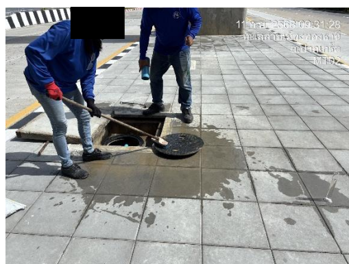
รูปที่ 2-3 การตรวจสอบระบบบำบัดน้ำเสียสำเร็จรูป
