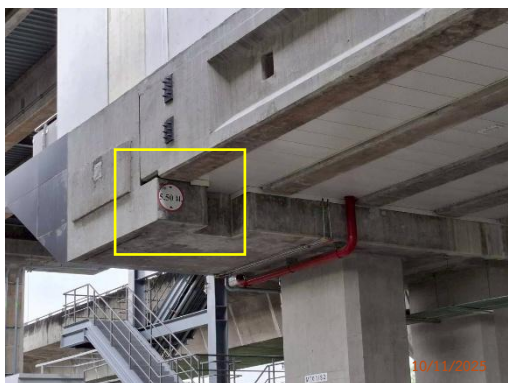
รูปที่ 2-8 ระยะความสูงของช่องลอดจากผิวจราจร (Vertical Clearance)
